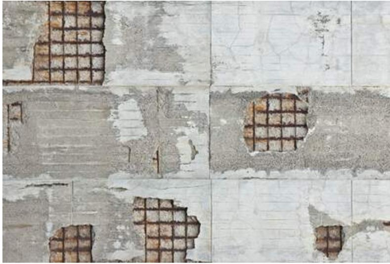
混凝土覆盖层、均质性和混凝土强度是确定您的结构是否有发生混凝土癌（腐蚀、开裂、剥落、失效……）风险的关键参数。
